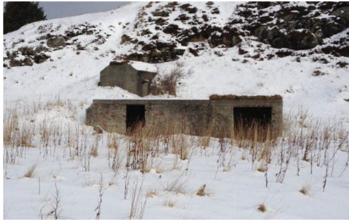
Bildet viser konstruksjonar frå 2. verdskrigen innanfor planområdet. Det næraste bygget er regulert vekk i gjeldande plan.
