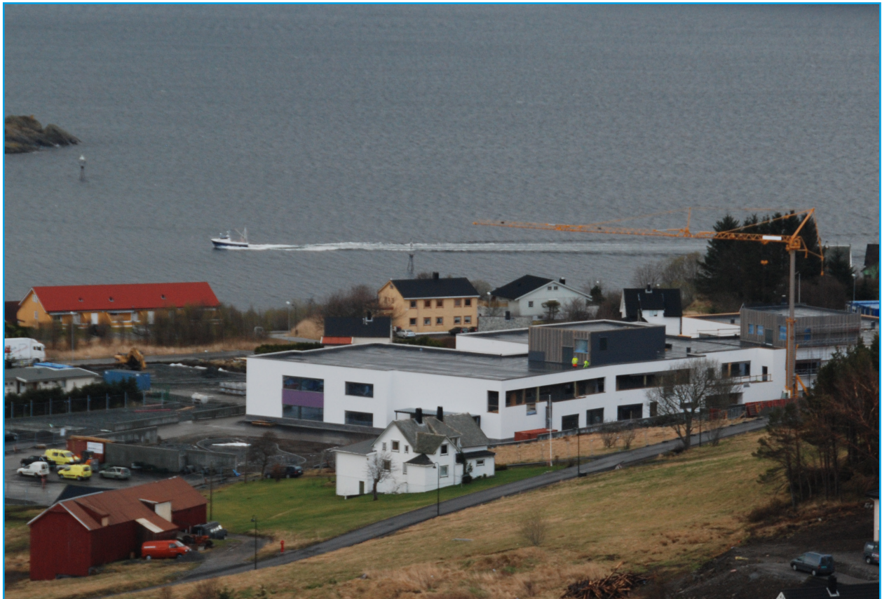
Nye Valderøy skule under bygging, 11.04.2014.
