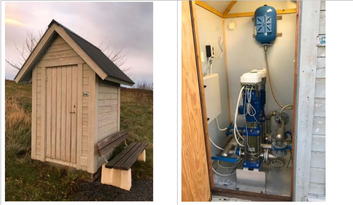
Figur 31: Skilderhusstasjon med to frekvensstyrte pumper og liten trykktank
