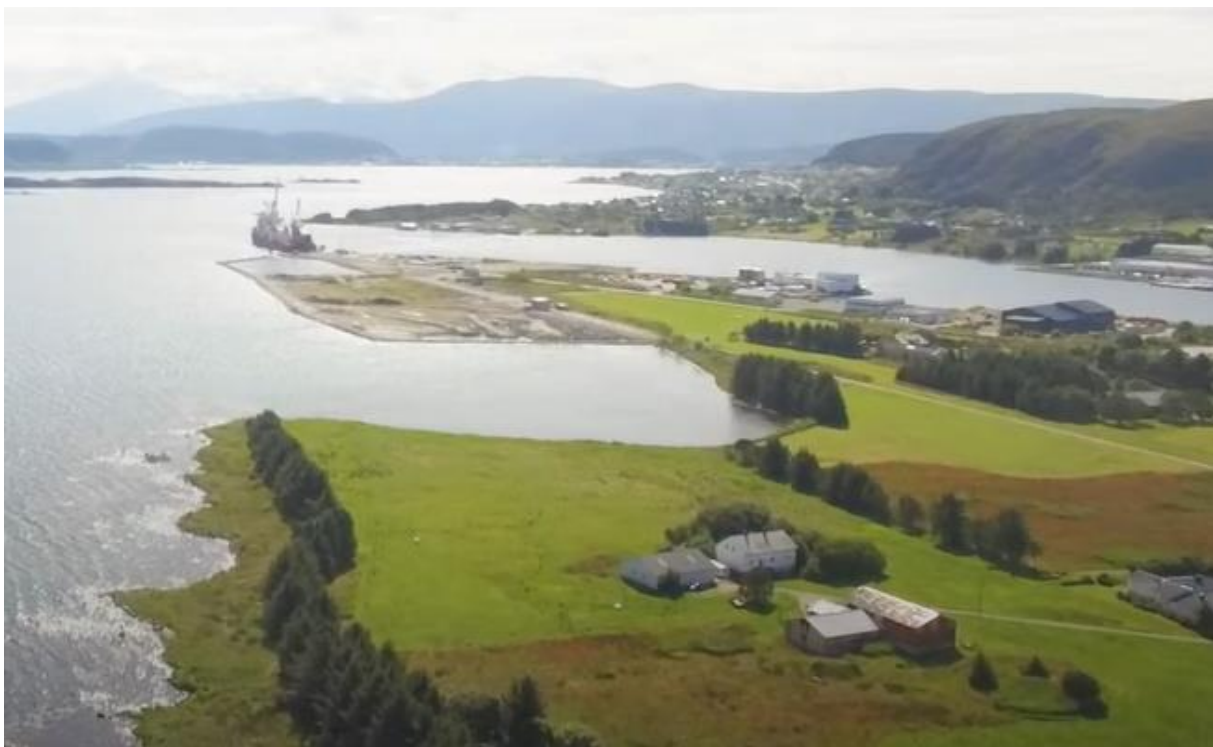
Figur 5. Olmannsvika sett mot sør, før sjetéen blei etablert.
